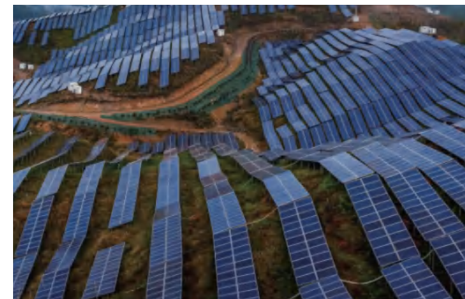
并网供电系统
